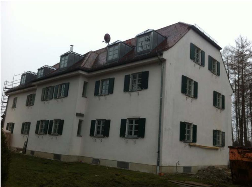
Der Putz wurde in 4 – 6 cm Stärke , je nach Unregelmäßigkeit des Mauerwerks aufgebracht.
